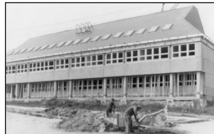
Bau des neuen Bürohauses der Firma Bony, 1985
