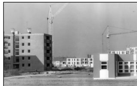
Bauarbeiten im Wohnviertel Fáy
